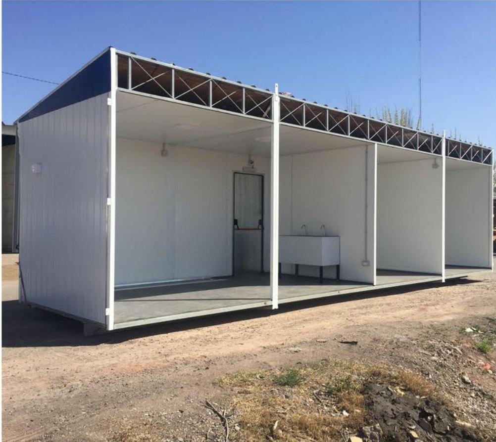
Creados a partir de un sistema semi continuo ensamblando paneles de techo, piso y pared. Este sistema permite que la creación del sea rápida y eficaz.
