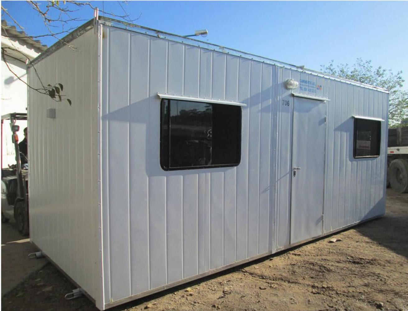
Creados a partir de un sistema semi continuo ensamblando paneles de techo, piso y pared. Este sistema permite que la creación del sea rápida y eficaz.
