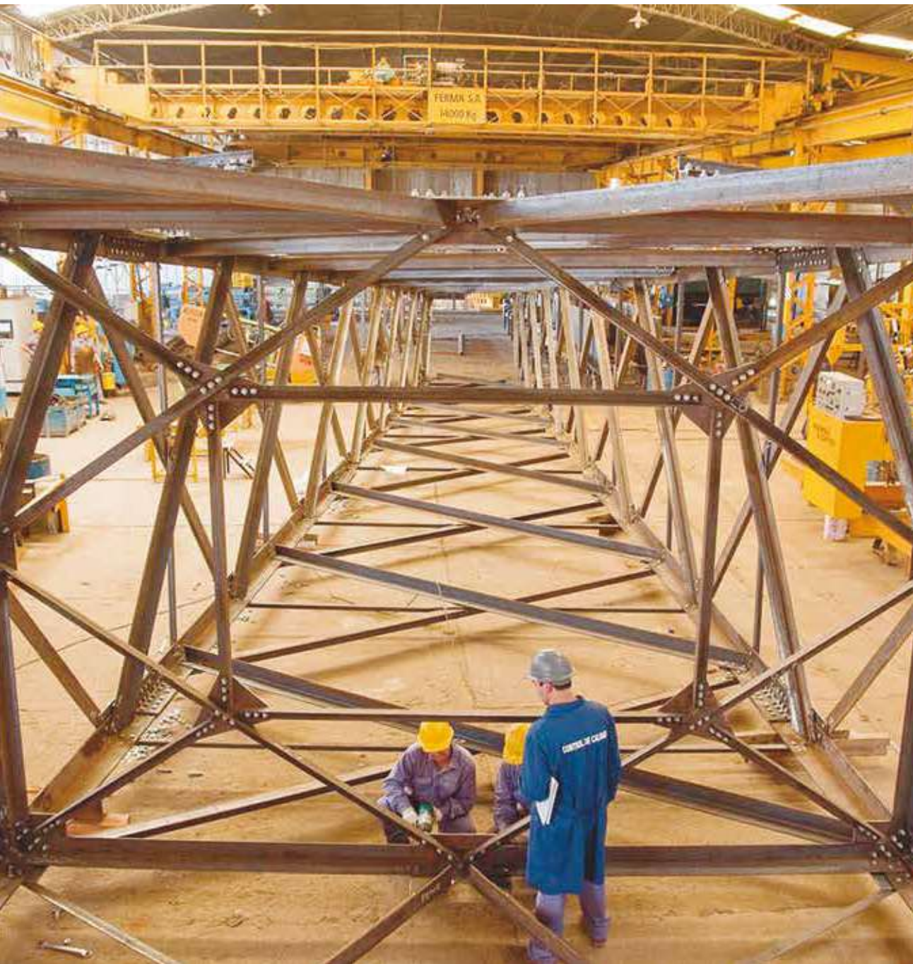
Pórticos de apertura 500 Kv. Arroyo Cabral, Córdoba.
