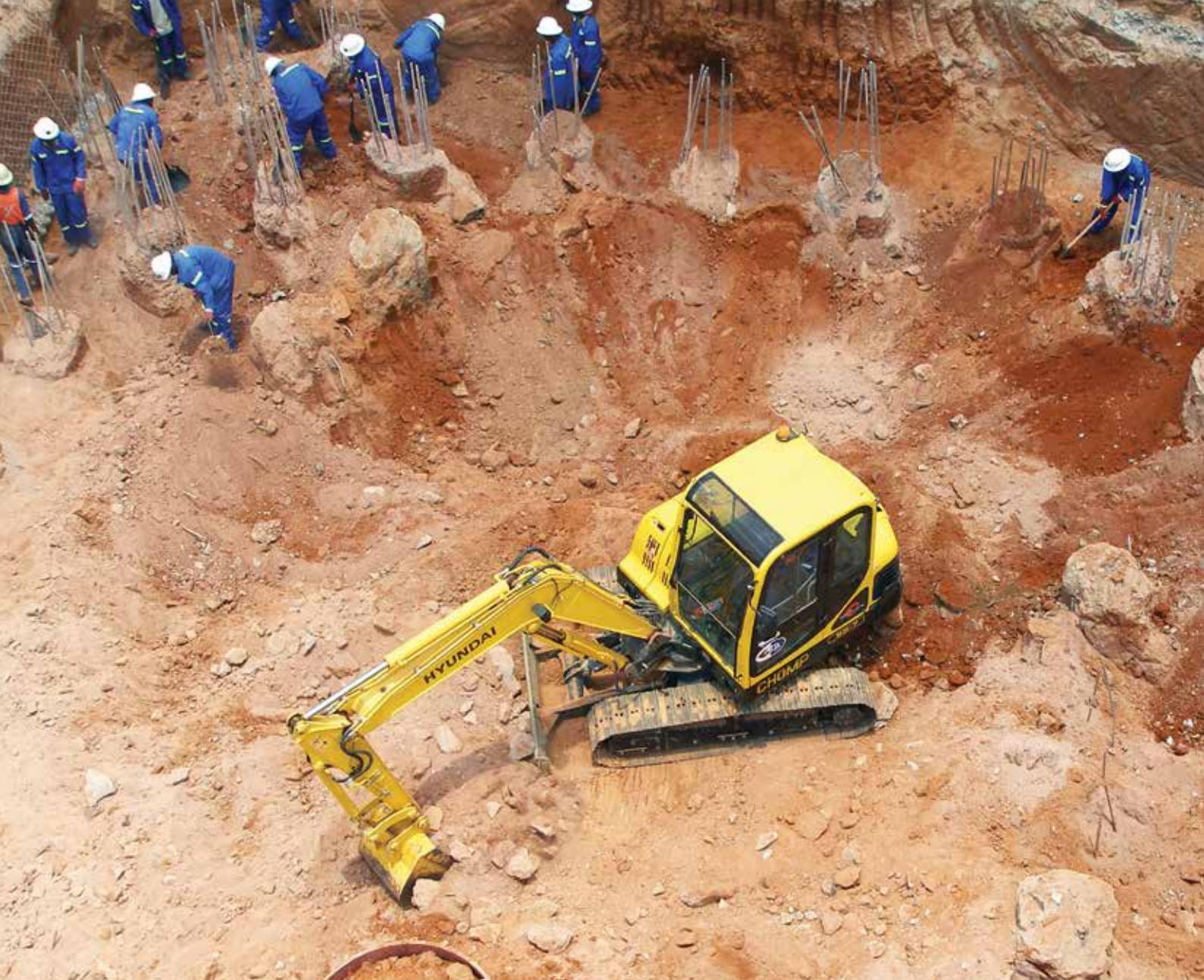
El comienzo – disposición superficial de fortificación lateral y pilotes para soporte de cargas, Konkola, Zambia
