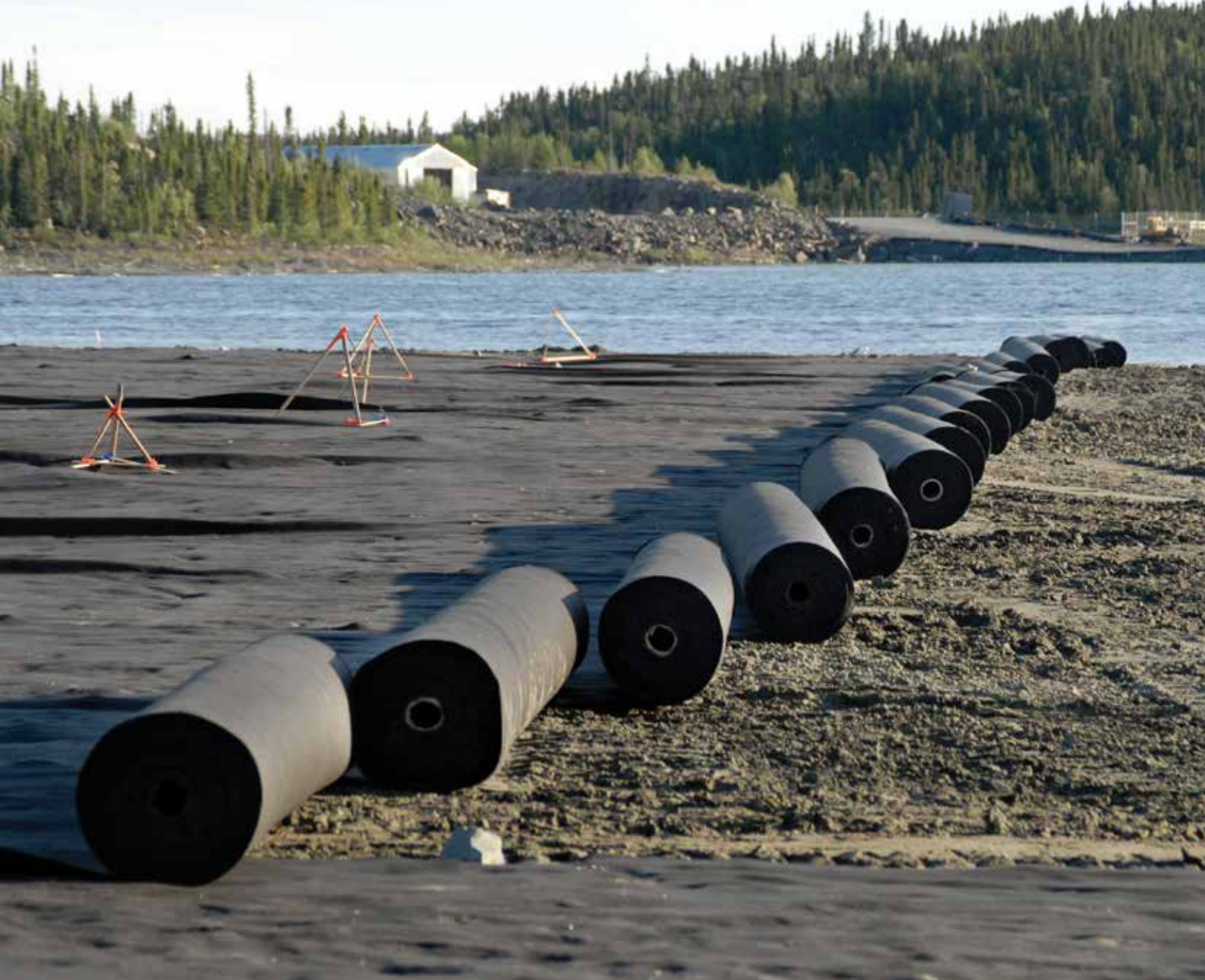
Construcción de una cobertura sobre relaves, Mina Colomac, Territorios del Noroeste, Canadá.
